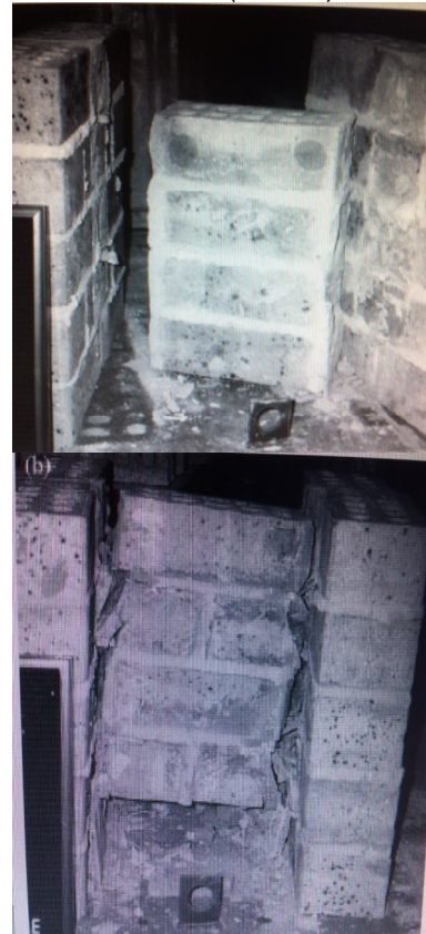
Figura 3 – Ruptura da alvenaria estrutural com amarração direta (cima) e amarração indireta (abaixo)
