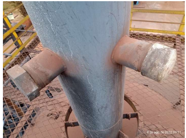
Figura 10: Pontos de amostragem na chaminé (Autor).
