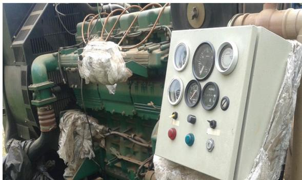
Figura 3. Gerador a Diesel modificado para GNC com ciclo Otto. Fonte: ONDATEC (2016)
