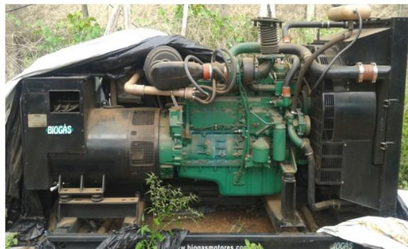
Figura 4. Gerador a GNC. Fonte: ONDATEC (2016).
